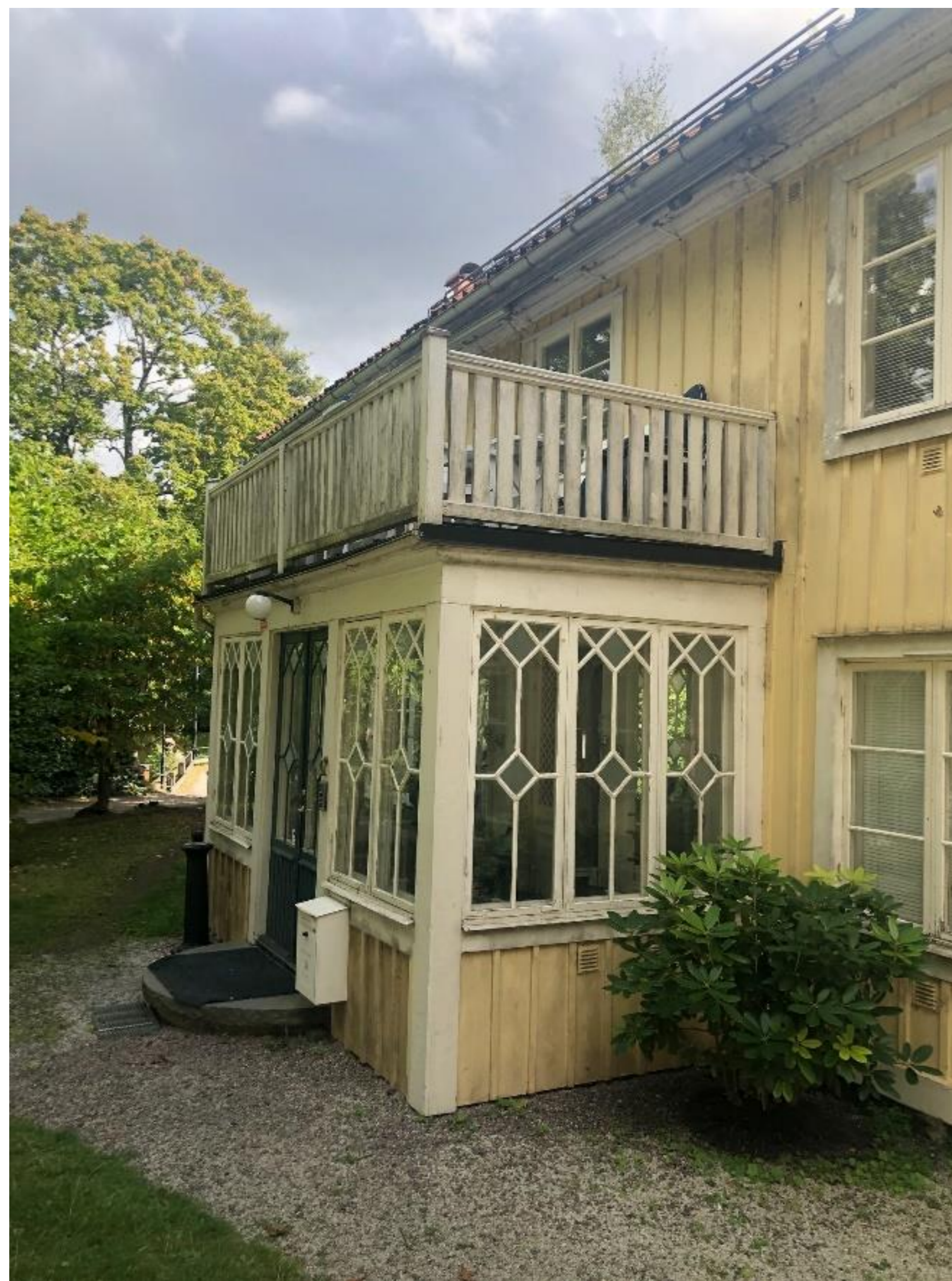
Huvudbyggnaden sett från gården. På bilden syns ursprunglig glasveranda med påbyggd balkong.
