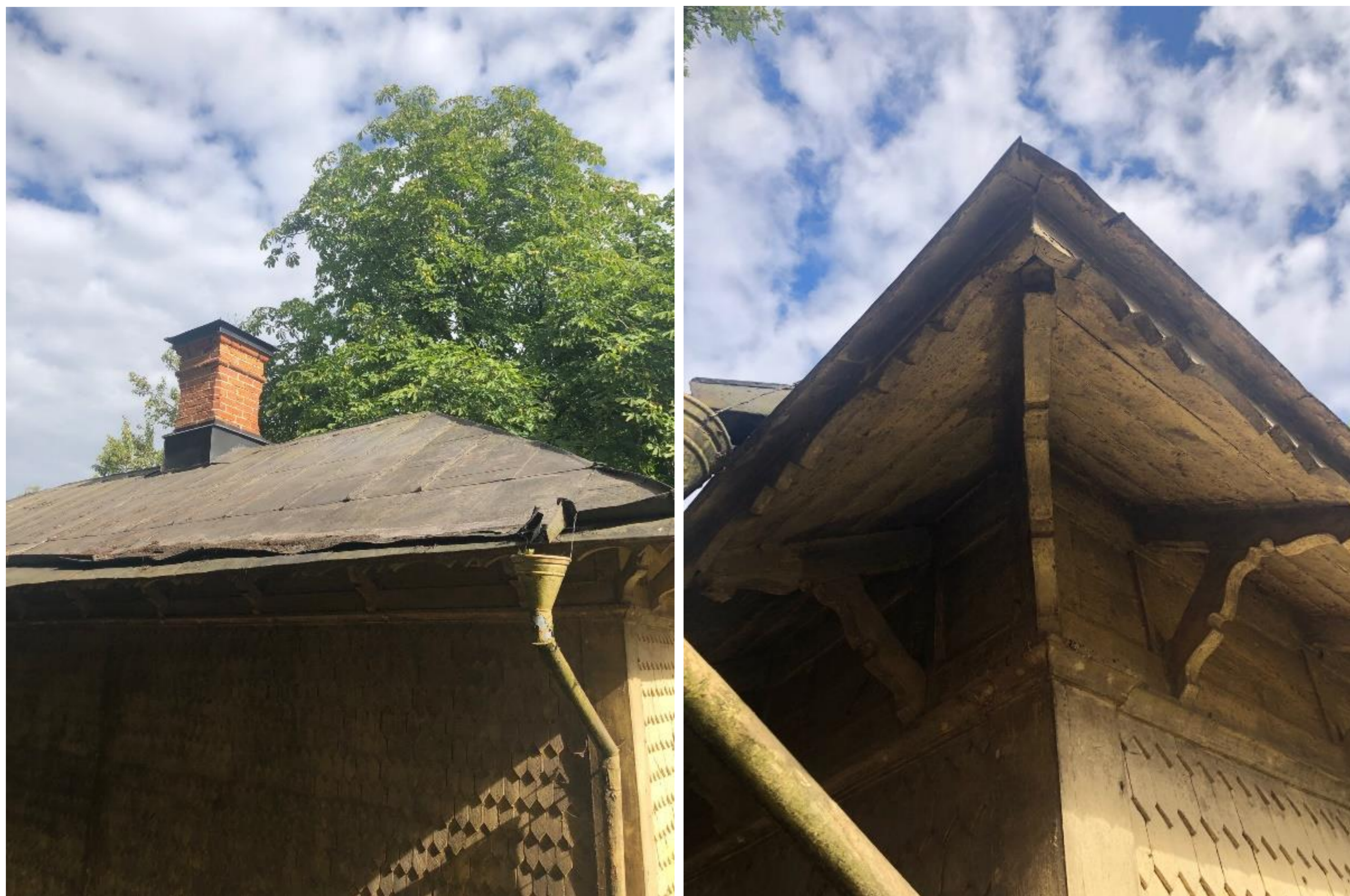
Gårdshuset. Här syns skorstenen samt del av de figursågade takfotskonsolerna.
