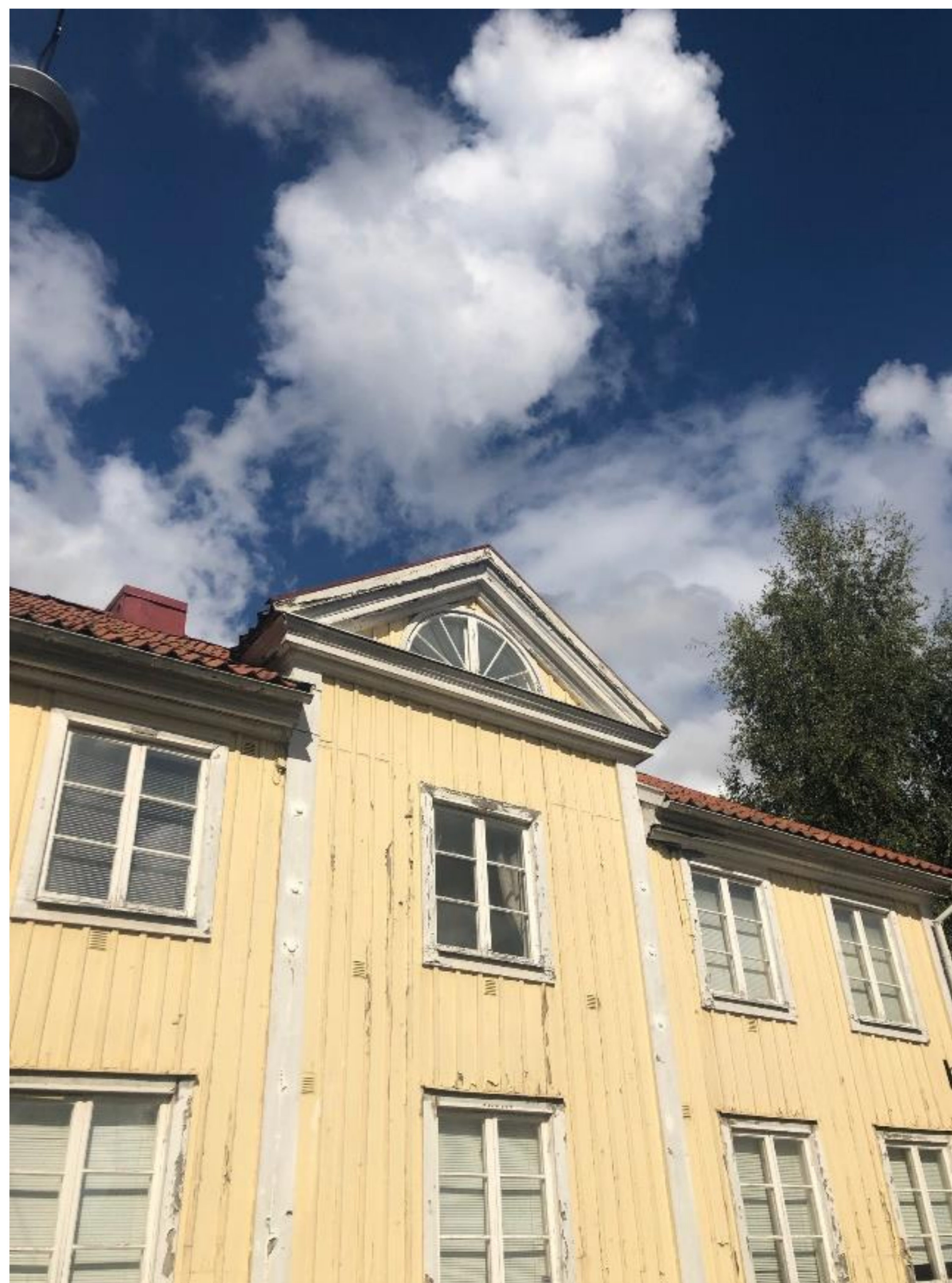
Huvudbyggnad sett från gatan. På bilden syns fasadpanel med profilerad lockläkt, profilerade listverk samt frontespis med lunettfönster.
