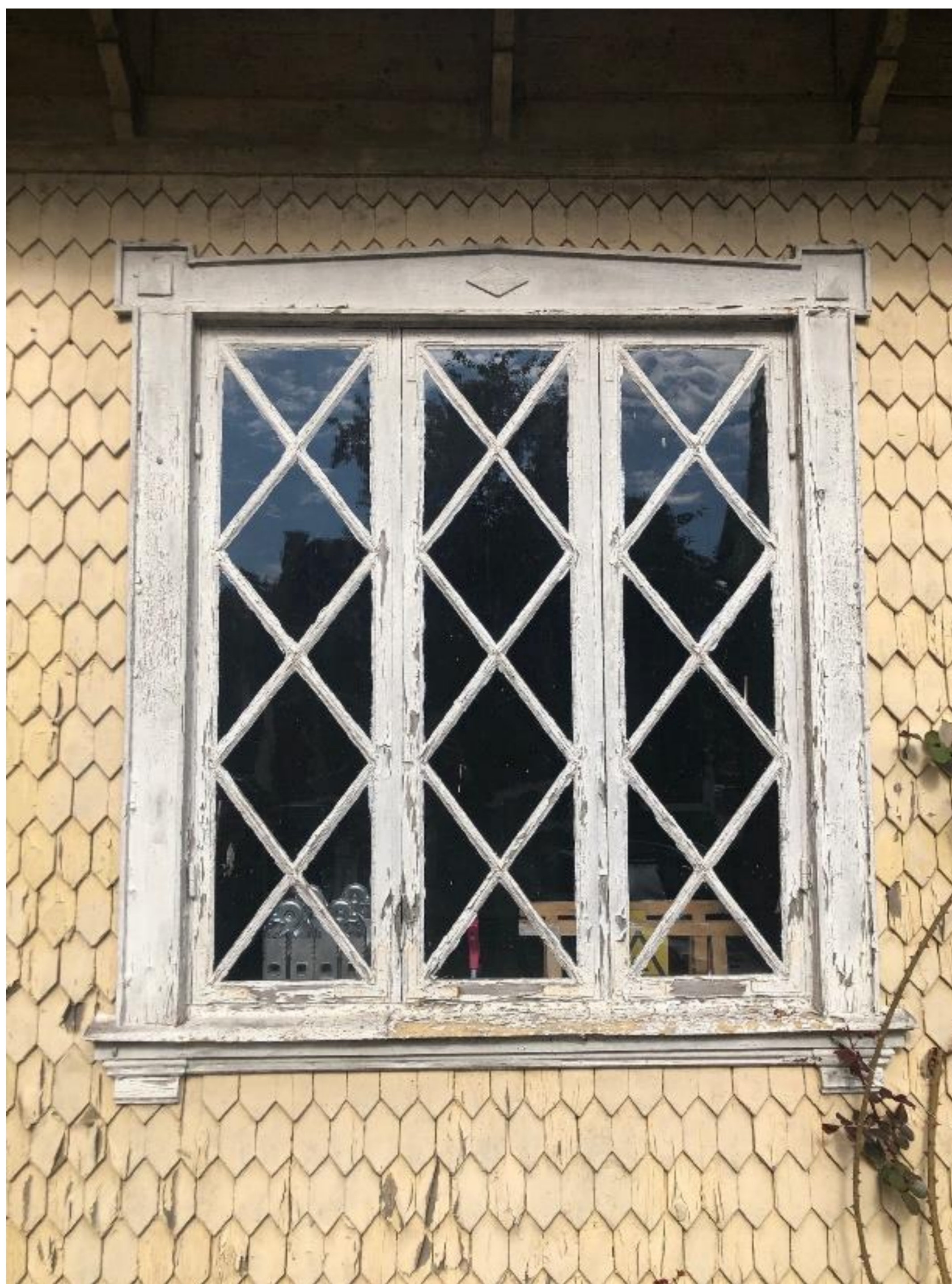
Gårdshuset. Här syns fönster och dess foder samt del av fasaden.
