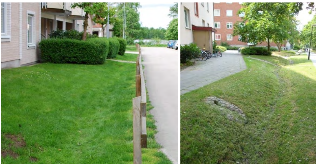
Figur 13. Exempelbilder på makadamdiken. Källa Sweco
